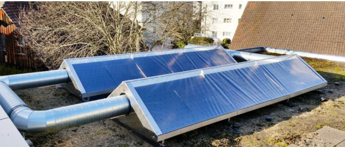
Pour chauffer ou sécher, le soleil élève la température de l'air et évite des émissions de CO<sub>2</sub>.
